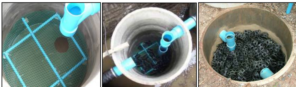
รูปที่ ๓.๑๓ การติดตั้งชั้นตัวกลางภายในบ่อกรองไร้อากาศ
